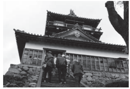
外観は下見板張り(上が白漆喰、下が板張り)の二重構造になっている。全国でも珍しい石瓦を持つ城でもある
