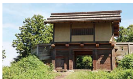
2階建ての櫓門が復元された郭馬出西虎口門。幅約5.7m、奥行き約3.5m、高さ約6.5m。井伊直政の時代に築かれ、櫓門としては当時の関東地方で最大規模を誇った
