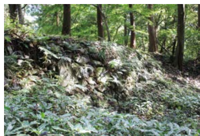
三の丸の石垣。城内では最も高い4.1mの石垣が確認されている。石は、城ののすぐ西を流れる榛名白川から運び上げられたと考えられている
